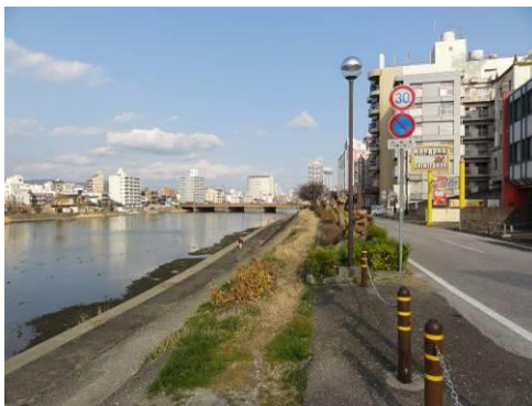
①鏡川右岸(土堤)の状況
