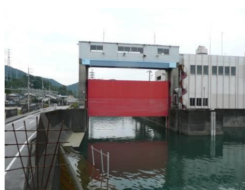
④孕橋より上流側の状況
