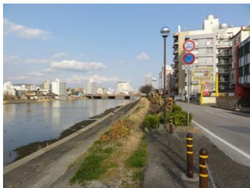
①鏡川右岸(土堤)の状況
