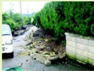
ブロック塀の倒壊による道路閉塞
