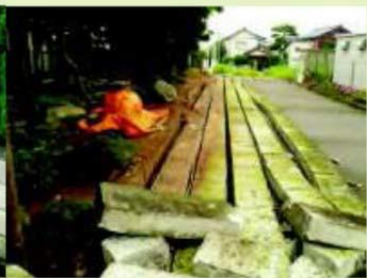
ブロック塀の倒壊による道路閉塞
