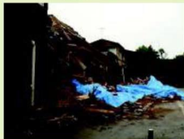
古い家屋の倒壊
