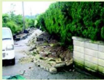
ブロック塀の倒壊による道路閉塞
