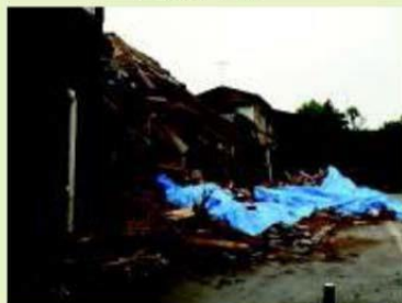
古い家屋の倒壊
