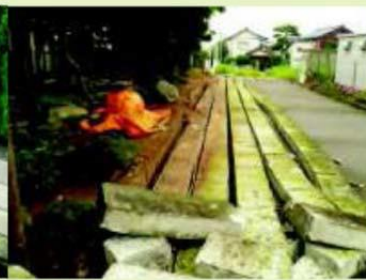
ブロック塀の倒壊による道路閉塞
