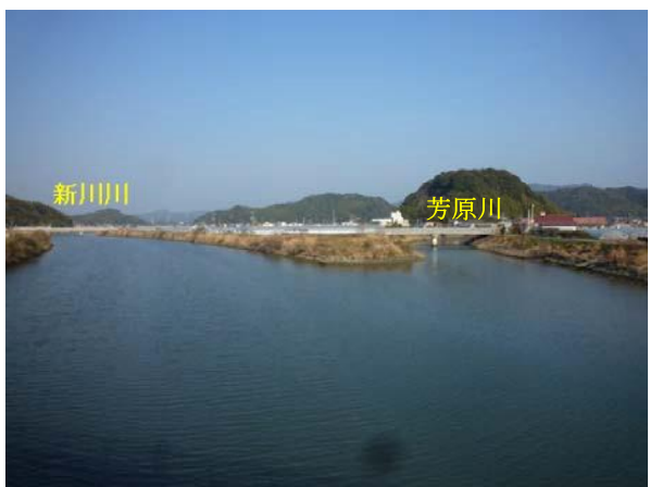
【写真8】 新川川中流護岸（西諸木）
