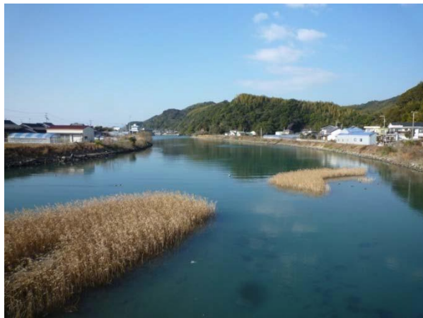
【写真6】 甲殿川護岸
