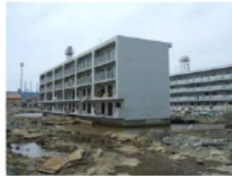
津波浸水後、地盤沈降により周辺が浸水 した石巻市内の住宅
