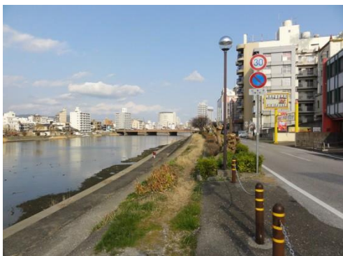
①鏡川右岸(土堤)の状況
