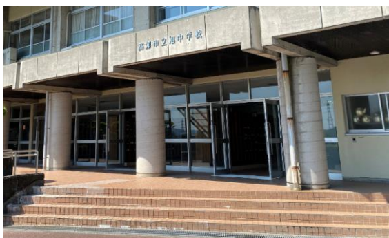
①昇降口：窓ガラスに割れはないか確認
