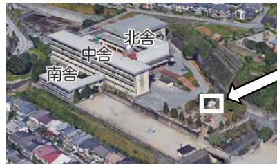
高知市 防災倉庫
