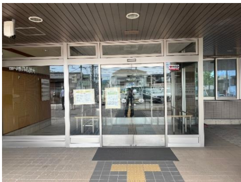
①玄関：窓ガラスに割れはないか確認
