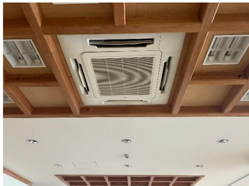
③天井：照明などの落下物がないか確認
