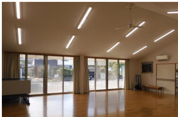
①内壁の落下、柱の損傷、窓ガラスの割れはないか確認（施設全体を確認）
