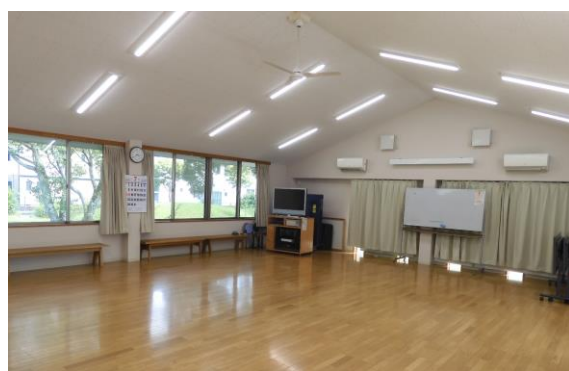
②天井：照明などの落下物がないか確認
