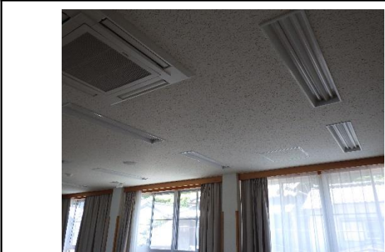
①大会議室：窓ガラスの割れ、崩れ落ちがないか確認
