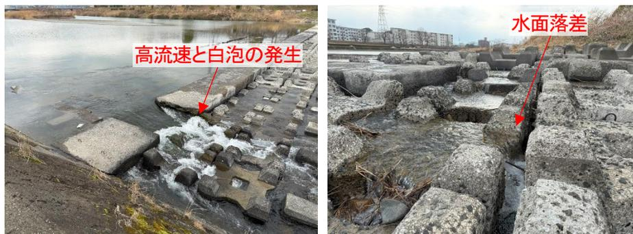
図 5-1 トリム堰の魚道の状況(左:右岸、右:左岸、2025 年 3 月 1 日撮影)
