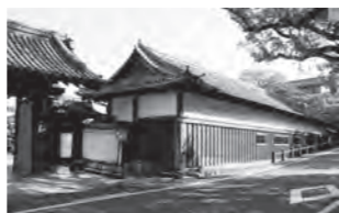
15 旧山内家下屋敷長屋展示館
