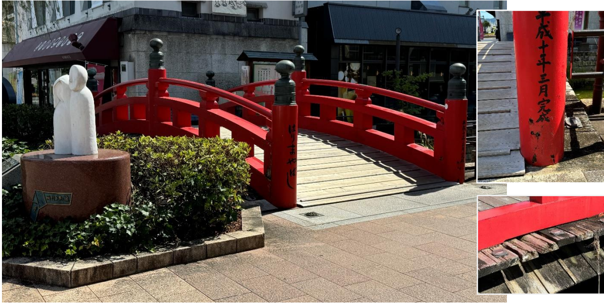
改修する公園内の木橋（はりまやばし）の状況
