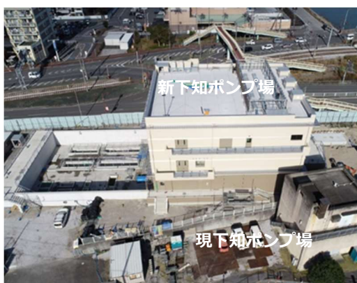
令和5年12月施工状況
