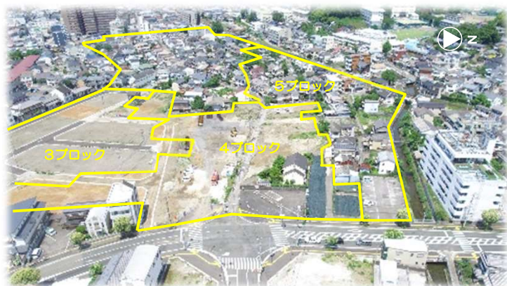
区画整理事業 施行中の状況
