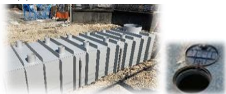
くみ取り式マンホールトイレの例
