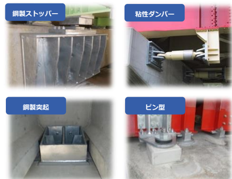
—水平力分担構造の例—
