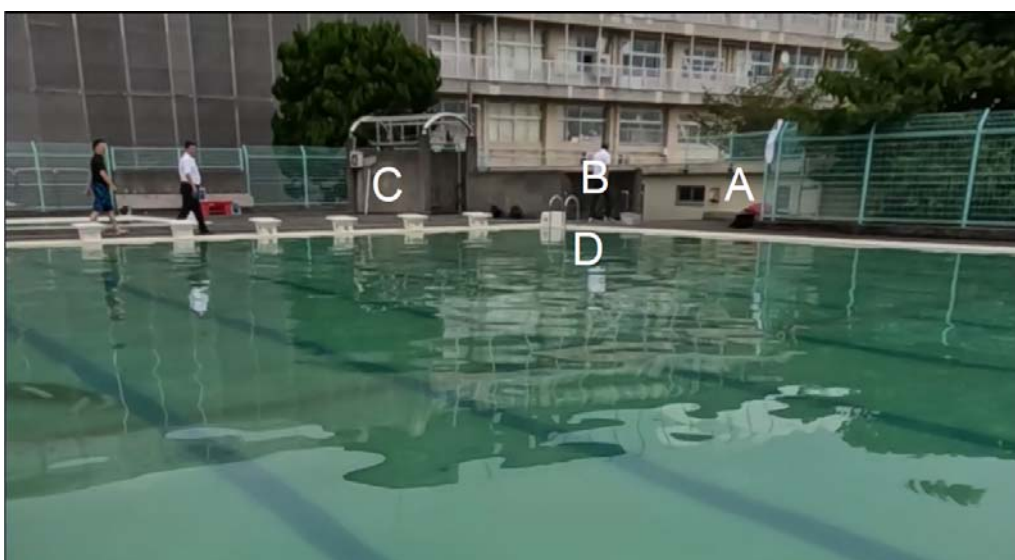
図 3 長浜小学校のプールの付帯設備
