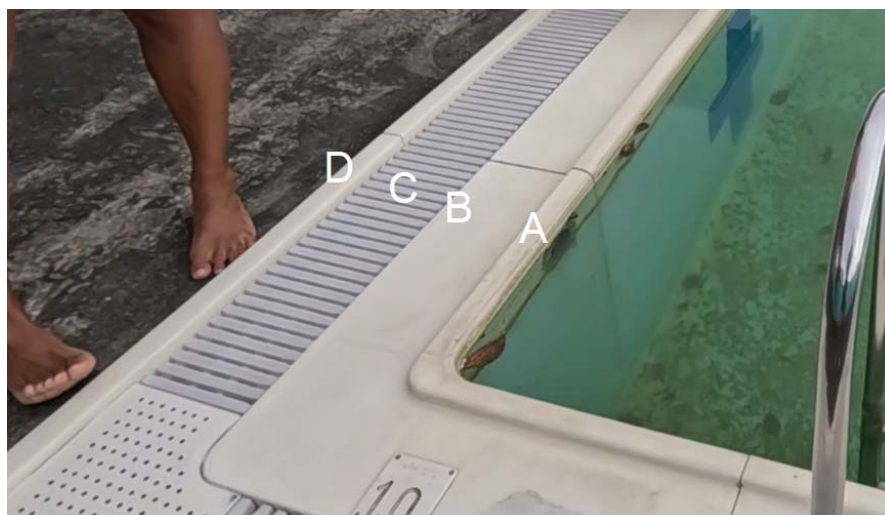
図 1 長浜小学校のプールのオーバーフロー。下方に写りこんでいる数字の 1.0 は m 単位で設計水深を示す
